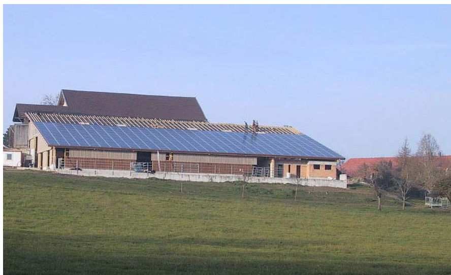
Source : La Gazette de la Société Suisse pour l'Energie Solaire - Installation du domaine "Le Petit Viry" (Barberêche)
